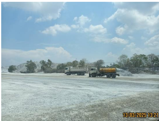
รูปที่ 3-24 ฉีดพรมน้ำบริเวณเส้นทางขนส่งแร่ ภายนอกพื้นที่โครงการ
