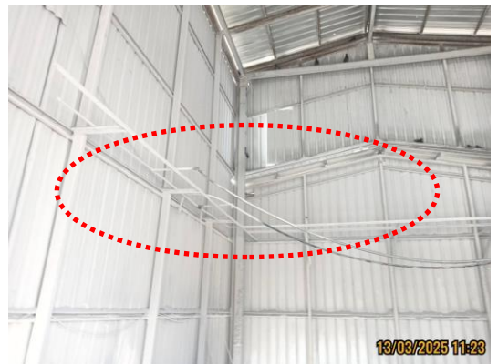
รูปที่ 3-16 ระบบสเปรย์น้ำบริเวณที่ทำให้เกิดฝุ่นละออง
