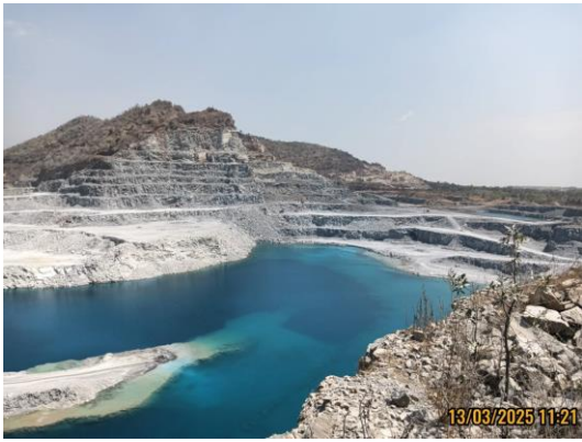
รูปที่ 3-13 บ่อดักตะกอน (ใช้ขุมเหมืองเก่า)
